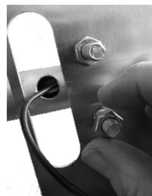
b) Fixer le tube avec les deux brides. Attention de ne pas coincer le câble d'antenne qui doit passer par le trou ovale.
